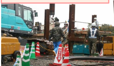
作業架台上に幅木設置
