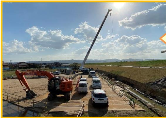
本日の作業は、27日からの矢板工に向けての施工準備をされていました。現場は風が強く、今後悪天候の日が多く予想されます。クレーン災害防止のためデジタル風速計と吹き流しが作業箇所などの位置からでも確認できるように設置されていました。看板やのぼり旗、吸殻入れなど飛散しやすいものはしっかりと固定され、飛散防止対策が徹底されていることを確認しました。無事故・無災害に向けて、そして地域の方の安全も守りながら、細部まで安全管理に取り組まれていると感じました。
