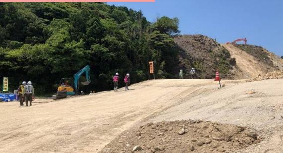
この現場は道路土工を主とする現場ですが、土工の他に橋台躯体工や橋脚躯体工、その他付属物等の工種が多くある現場で、工種ごとに同時進行で施工を行うため管理者側の苦勞がうかがえました。安全面では近隣住民への配慮として防音柵や騒音・振動計が設置されていました。他にもデジタル式の熱中症測定器や架空線接触防止対策など様々な安全施設の取組が徹底されています。広い現場ですがどの安全施設も高さや幅が揃っており、現場全体が綺麗に整えられていました。
