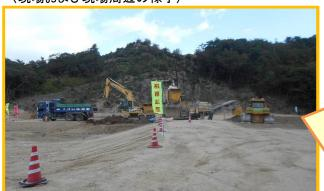
この現場は道路土工の路体盛土工が主な工種となります この現場は退路工工の路体盛工工が主な工種となりますが、3次元設計データを駆使して敷均し(マシンコントロール付ブルトーザ)、転圧(締固め管理システム付ローラー)、法面整形(マシンガイダンス付バックホウ)の作業内容をICT活用工事として取り組んでおられます。1回目のパトロールでは86,000m3の路体盛土の内36,000m3の路体盛土が完成していました。これは小学校プール(25m×20m×1.5m)でいうと115杯分の内48杯分に相当します。さ らに追加で法枠を造成して間に種子を吹き付ける工種も 別箇所で施工されていました。重機混在作業が多く、ダン プ等の出入りが激しいため路肩旗やカラーコーンで注意 喚起を促す工夫がされています。
