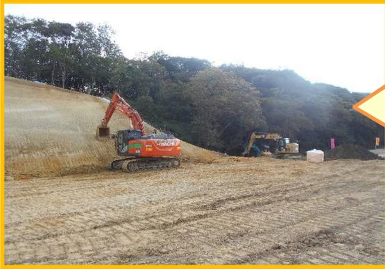
この現場は道路土工の掘削と盛土が主な工種となりますが、3次元設計データを駆使して掘削(マシンガイド付きバックホウ)、敷均し(マシンコントロール付きブルドーザー)、転圧(締固め管理システム付きローラー)の作業内容をICT活用工事として取り組んでおられます。さらにカルバート工として場所打ち函渠も24.4m造作しておられました。道路土工だけでなく付属する工種が多いため施工管理が難しい工事だと思われました。1回目のパトロールでは掘削作業と排水構造物の施工を行っておられました。立入禁止区域の明示と安全通路の確保で安全対策が徹底されていることが分かります。
