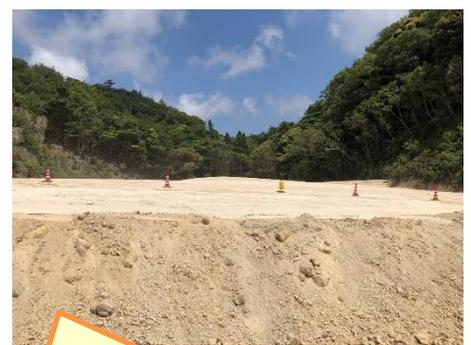
この現場は道路土工の路体盛土を主とする現場ですが、最終段まであがっており、付属構造物も一部完成していました。施工完了範囲を明確に区切っておられます。土の粉塵を抑えるための水が確保できず場内に砂埃がおきるとの説明を受けました。砂埃も吸い込まないように引き続きマスクの着用をお願いします。
