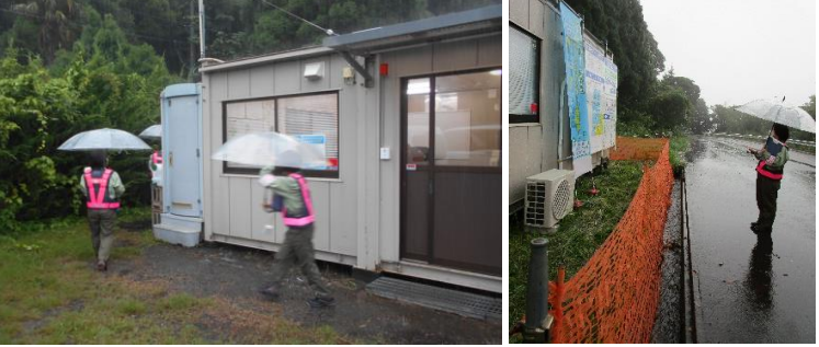
現場事務所周辺も綺麗な状態が保たれています
