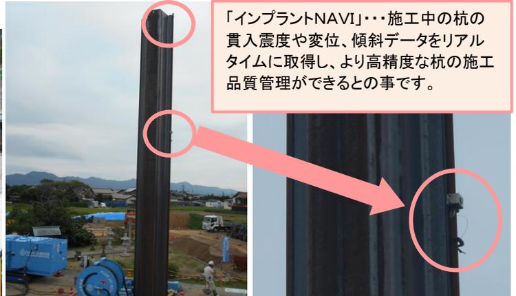
「インプラントNAVI」・・・施工中の杭の貫入震度や変位、傾斜データをリアルタイムに取得し、より高精度な杭の施工品質管理ができるとの事です。
