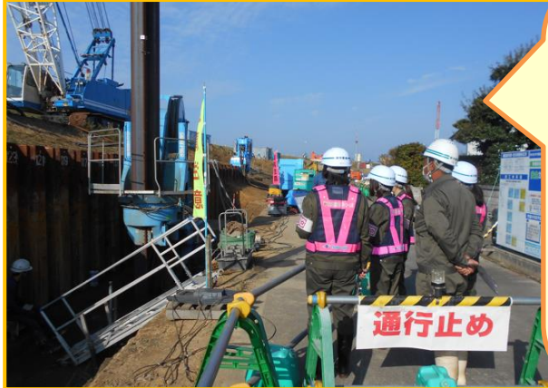
鋼矢板溶接作業
