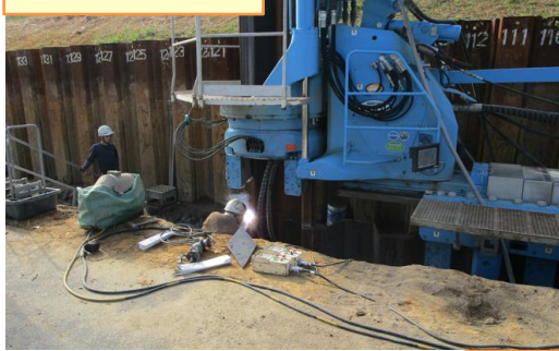
鋼矢板溶接作業
