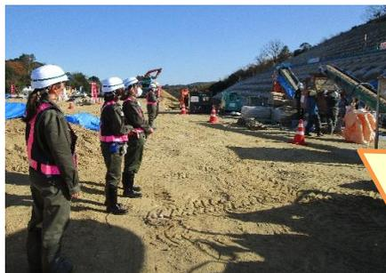
現場は、上から4段目の小段施工が完了し、法面アンカー工5段目の作業床までの掘削、それに伴う残土運搬を行っておられました。
