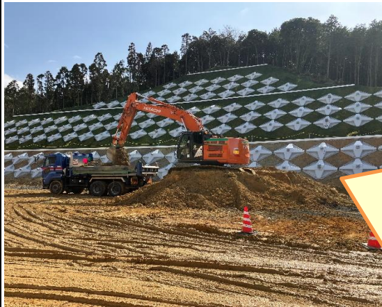
アンカー工完了
