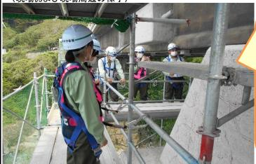
この工事で修繕する帆掛橋は、橋台・橋脚にア ルカリシリカ反応によるひび割れが発生していま す。さらに、海からくる潮風により塩害も起きてお り、ひび割れがさらに悪化して崩壊する危険な状 態になっていました。
