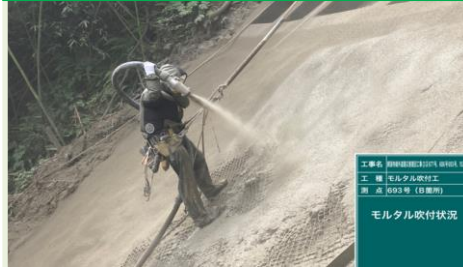
【693号(B工区)】法枠・モルタル吹付完了
