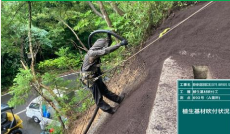
【693号(A工区)】植生基材吹付完了
