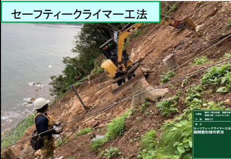
落石防護柵設置
