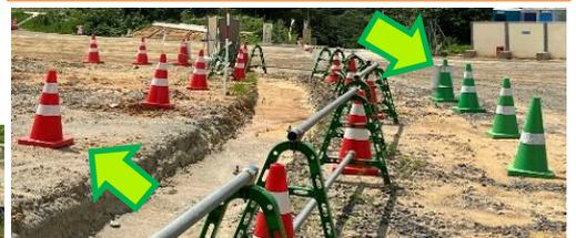
【提案】安全通路や作業エリアの明示にカラーコーンだけでなくコーンバー等を使い、境界線を明示することを検討して下さい。
