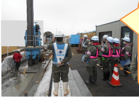
施工中の鋼矢板
