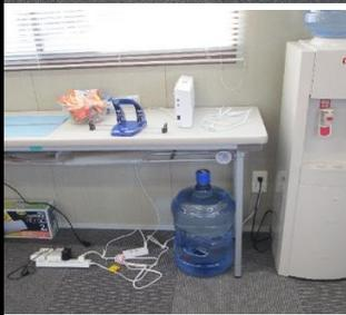
【指摘事項】配線が乱雑に置いてありました。配線を整えて下さい。また、水タンクが近くにあるとこぼれたときに漏電するので、コンセントの配線は別の場所へ移設して下さい。
