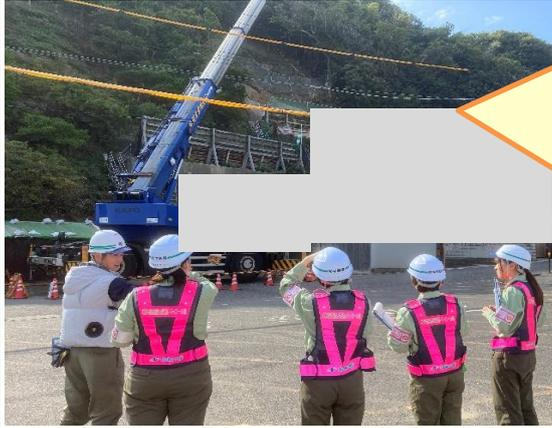
この現場は、豪雨により土砂崩れが発生した場所に、格子状のモルタル枠【吹付法枠工】を施工します。また、既設落石防護柵の腐食箇所を新しい材料に取り替えます。
