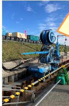
現場は矢板施工が完了していました。本日は圧入機の解体作業など機材の片付け中でしたが、安全に留意し作業が進められていました。
