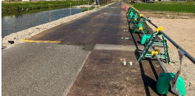
作業ヤードや現道(堤防天端)はシート養生した上に敷鉄板を設置して保護されていました。敷鉄板には溶接板や段差カバーが設置されていました。
