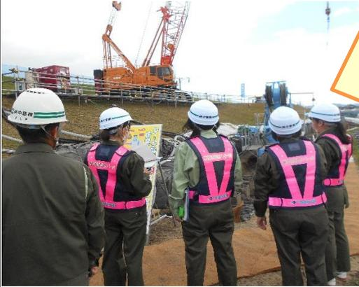
本工事は、神戸川堤防の堤防裏法尻付近において軟弱地盤対策として広幅鋼矢板を施工する工事です。これにより、堤防体である築堤盛土の土圧による地盤沈下から近隣住宅を守ることができます。
