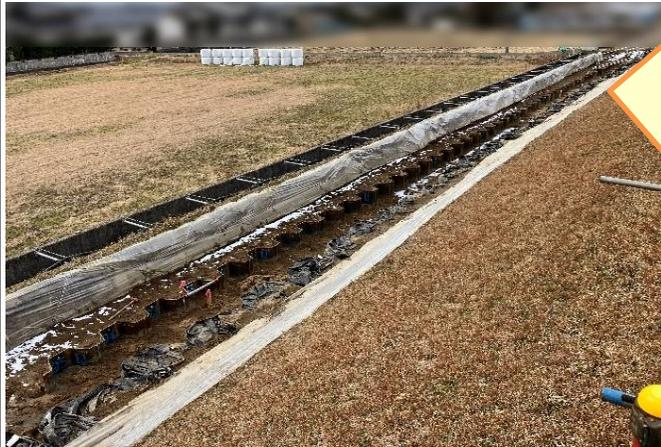
パトロール実施日には矢板施工が完了し、埋め戻し作業と仮設備の解体作業を行っておられました。工期が短い中、矢板枚数も多く、施工範囲も広いので、苦労されることが多かったと思いますが、工期内に施工完了できるよう工程管理を工夫されていました。
