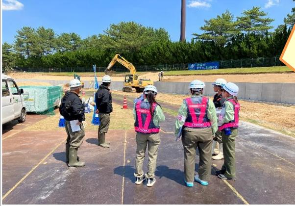
この現場は、2030年に島根県で開催される国民スポーツ大会に向けて、浜山公園にある野球場を改修する工事です。中筋組は外野部分の施工を行います。プロ野球の球場規定を満たすように、今までよりグラウンドを広げる整備を行います。本日の作業はスタンドの芝の基盤となる土(真砂土)の敷均し作業、スコアボード前面のコンクリート舗装作業を行っておられました。工事着手前に野球場の3次元モデルを作成され、発注者との不可視部の打ち合わせに活用されていました。またAR技術を用いた現地確認や工事進捗状況の動画作成にも活用されているそうです。(BIM/CIM活用)
