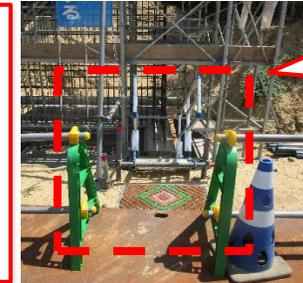
**【指摘事項】** 擁壁工の足場にある昇降階段に立入禁止措置の明示をお願いします。
