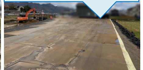
【道路汚損防止対策】敷鉄板の下に土木シートが設置されています。
